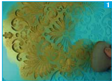
Farbaufrag mit dem Spezialschwamm
