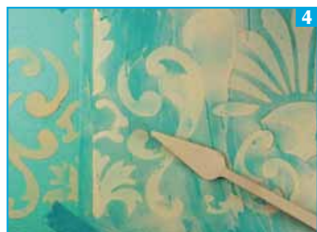
Die Stuckeffektfarbe aufspachteln
